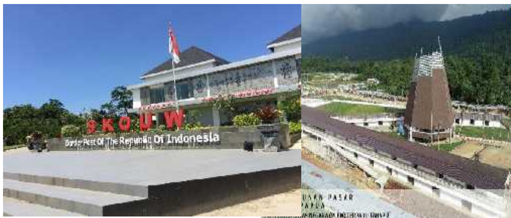
Gambar 2 Pos Lintas Batas Negara dan pembangunan pasar tradisional Skouw
