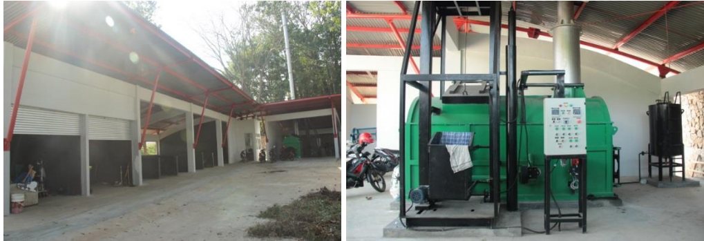
Gambar 3.24 Instalasi Pengolahan Sampah
