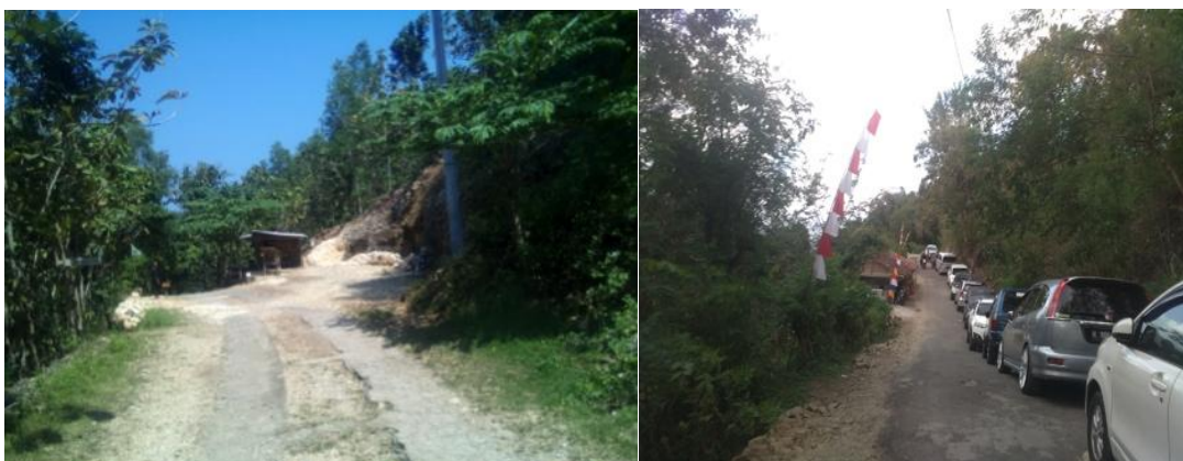
Gambar 3. Akses jalan aspal yang rusak ke Pok Tunggal (kiri) dan lebar jalan yang kurang memadai menuju Kalibiru (kanan)
