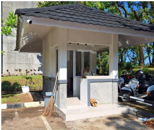
Gambar 21. Pembangunan Pos Satpam FISIP
