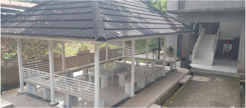
Gambar 18. Pembangunan Gazebo 2 FISIP
