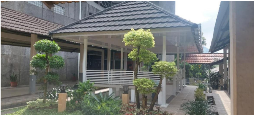
Gambar 17. Pembangunan Gazebo 1 FISIP
