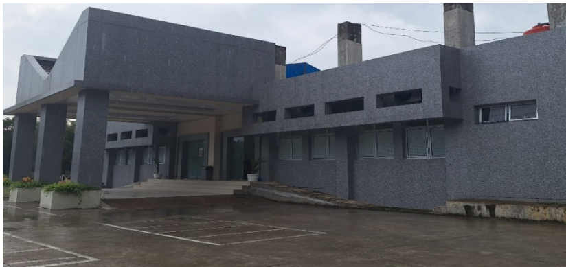
Gambar 19. Pembangunan Gedung Convention Hall FISIP Tahap I Tahun 2022
