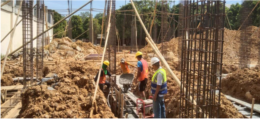
Gambar 20. Pembangunan Gedung Convention Hall FISIP Tahap II
