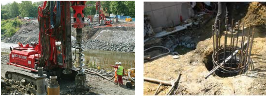
Penyiapan Bore Pile
