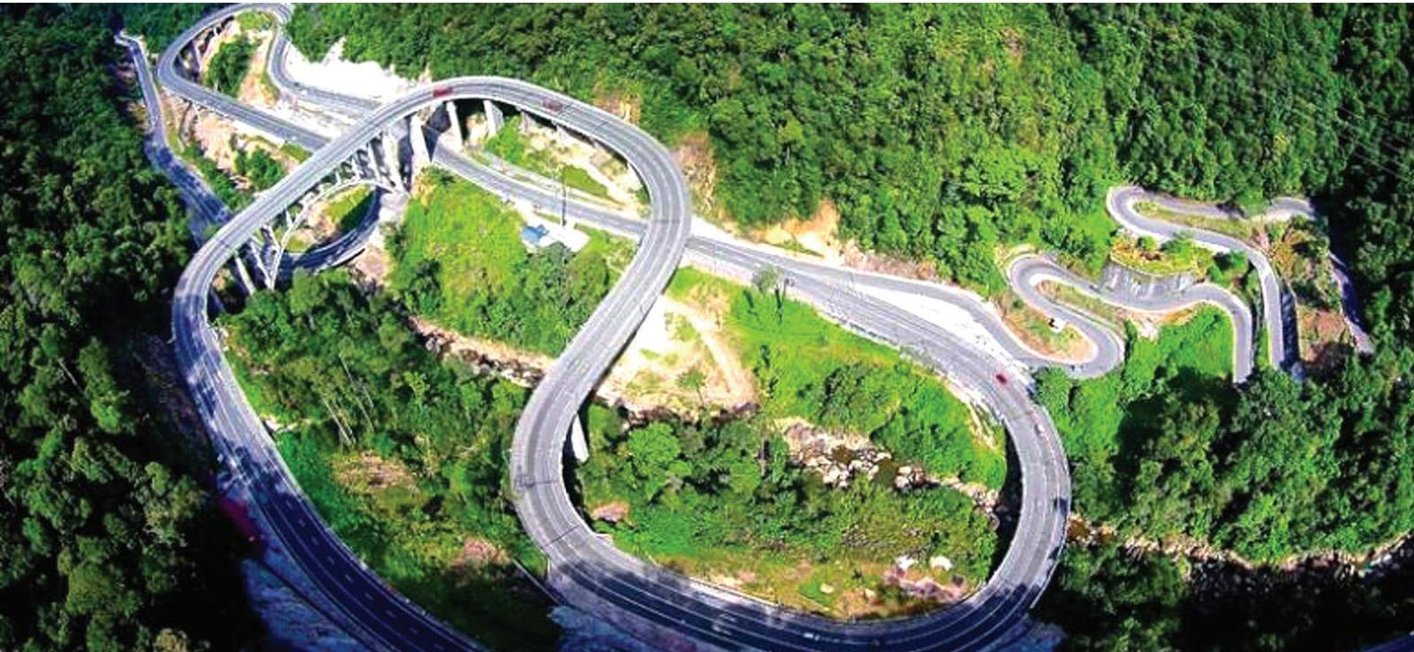
Jembatan layang itu disangga oleh tiang-tiang beton yang tingginya bervariasi tapi yang tertinggi adalah 58 meter.
