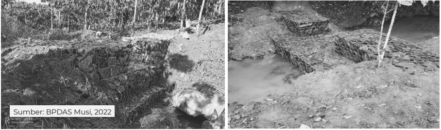
Gambar 4. Bentuk konstruksi Bangunan Gully Plug dan Dam Penahan air (RHL Sipil Teknis) Dalam kegiatan Rehabilitasi Lahan
