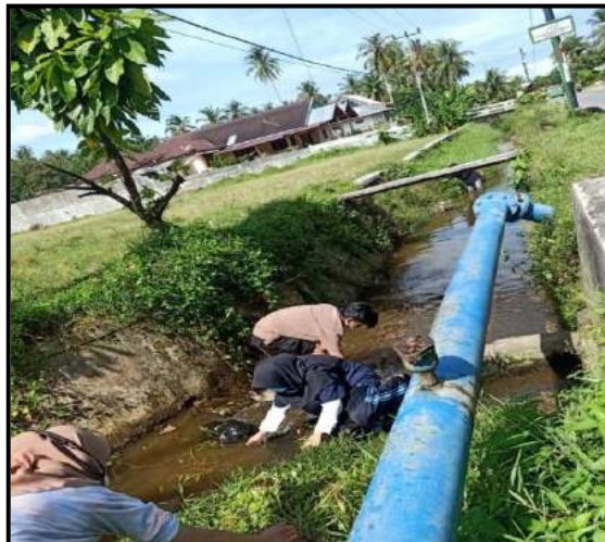
Gambar 3-4. Menjaga kebersihan sanitasi lingkungan di saluran drainase.
