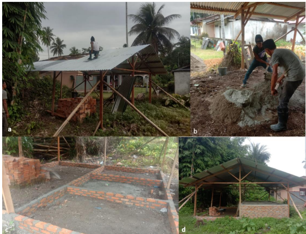
Gambar 7. Tahapan pembangunan rumah kompos di Kelompok Usaha Tani, Nagari Sungai Abang. Kecamatan Lubuk Alung. a. Pemasangan atap, b.
