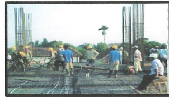
Untuk pengecoran plat lantai semua menggunakan alat concrete pump
