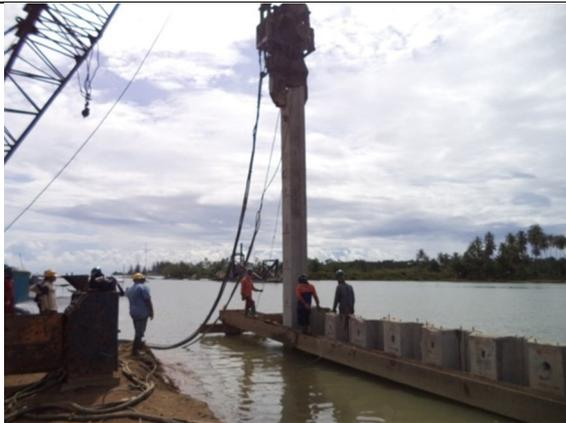
Gambar 5 : Pemasangan sheet piles beton pada sisi kiri Batang Anai
