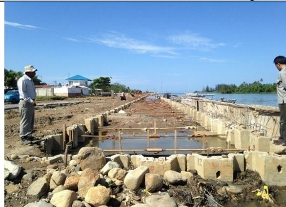
Gambar 6 : Pemasangan *tie rod* pada aliran sungai
