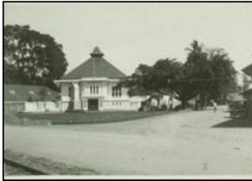
Gedung De Javasche Bank Padang
