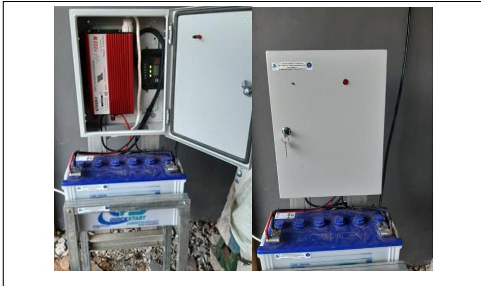
Gambar 3. Panel box dan sistem inverter PLTS
