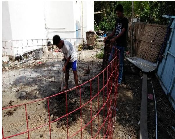
Gambar 1. Konstruksi besi kolam terpal bundar
