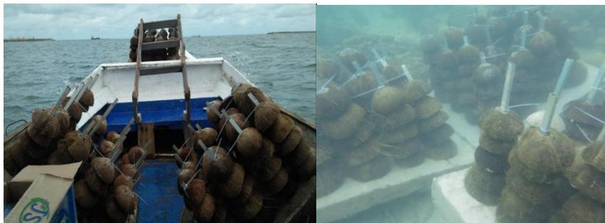
Gambar 1. Pengangkutan dan Pemasangan Bioreeftek
