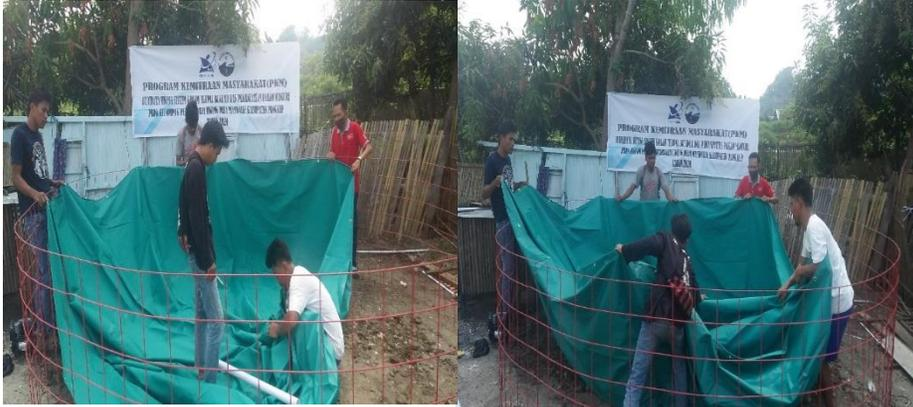
Gambar 2. Pembuatan saluran pembuangan dan pemasangan terpal
