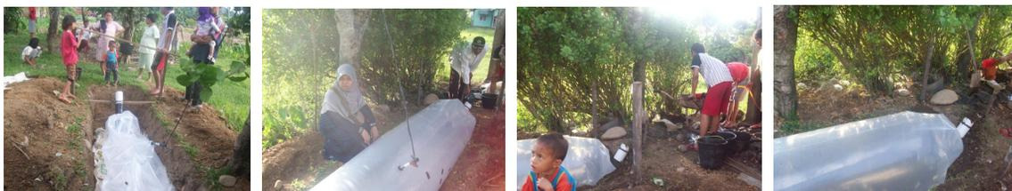
Gambar 3 Pemasangan instalasi biogas plastik
