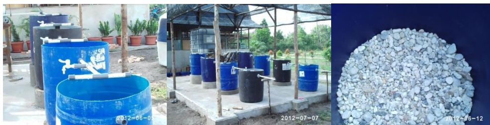
Gambar 2. Perakitan dan Pengisian Media pada Bak yang sudah dirakit
