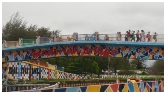
Gambar 5.7 Jembatan Warna-Warni di Pantai Gandoriah Sumber: Olahan Peneliti, 2020
