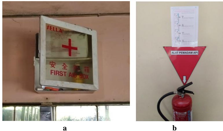
Gambar 1. a. Peletakan P3K, b. Alat pemadam kebakaran
