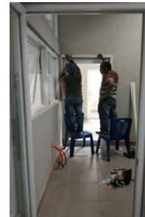
d. Gas dan Instalasi
