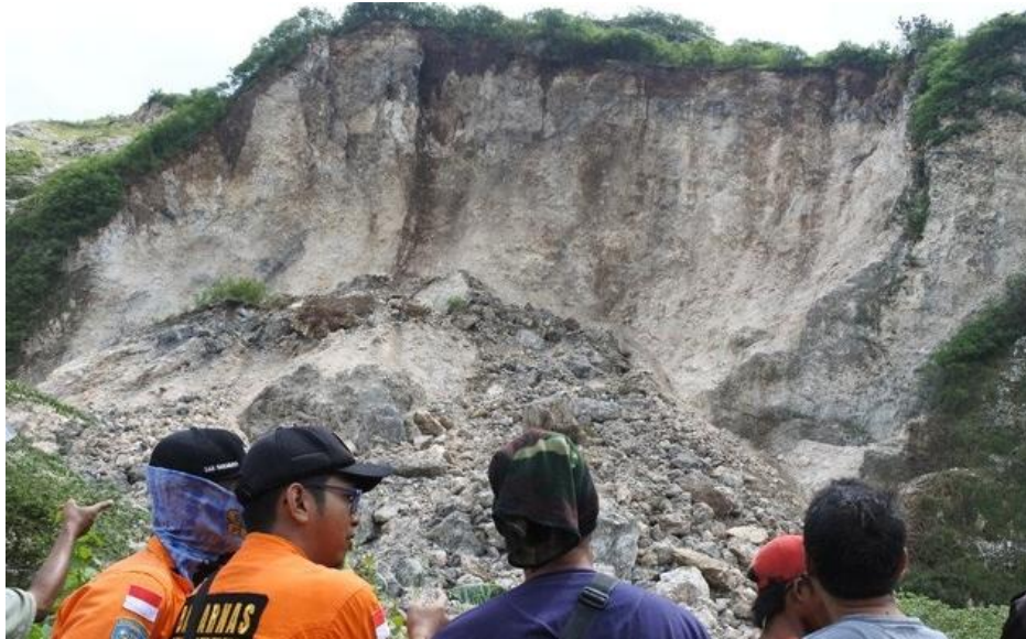
Gambar 4.7 Longsor Batu Kapur di Jember (Antara, 2019)
