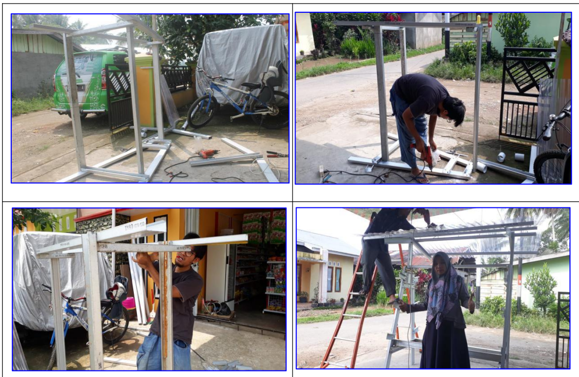
Gambar 6. Proses pembuatan instalasi hidroponik dengan baja ringan
