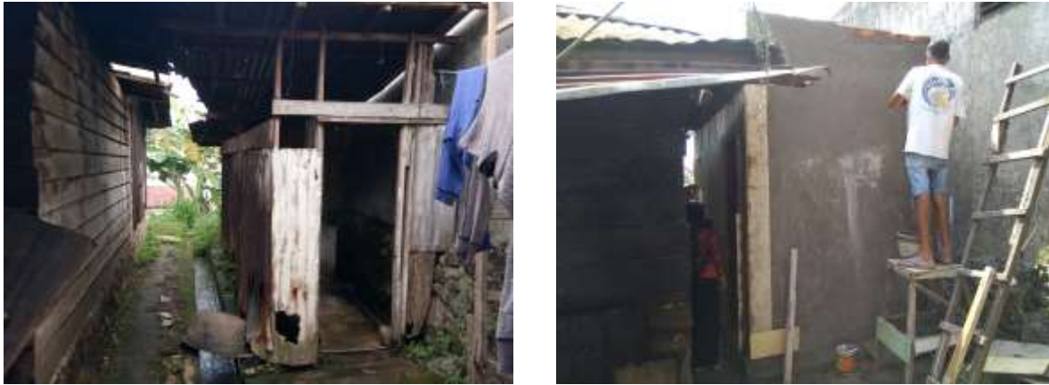
Gambar 4.3 Kondisi MCK sebelum (Kiri) dan setelah 75% (Kanan) Pelaksanaan Program Kotaku di Kelurahan Pakan Kurai
