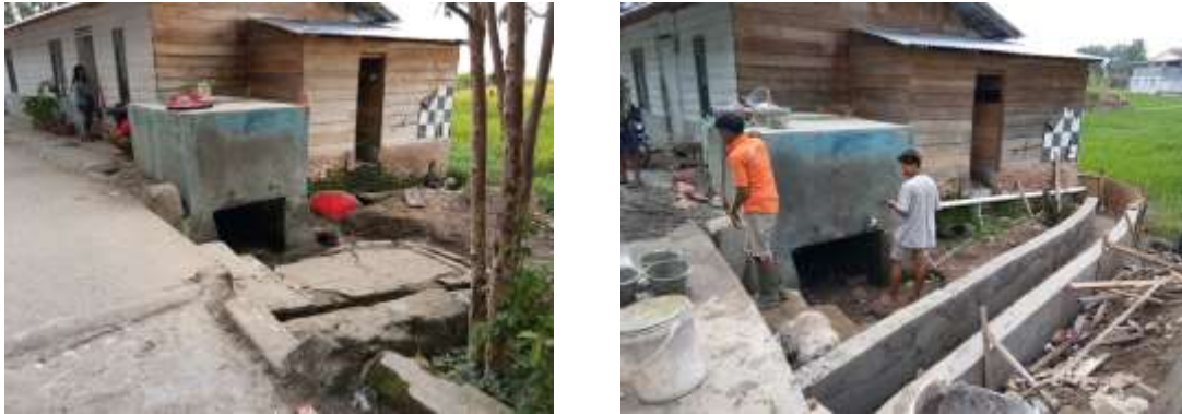
Gambar 4.2 Kondisi Drainase sebelum (Kiri) dan setelah 50% (Kanan) Pelaksanaan Program Kotaku di Kelurahan Aua Tajungkang Tengah Sawah
