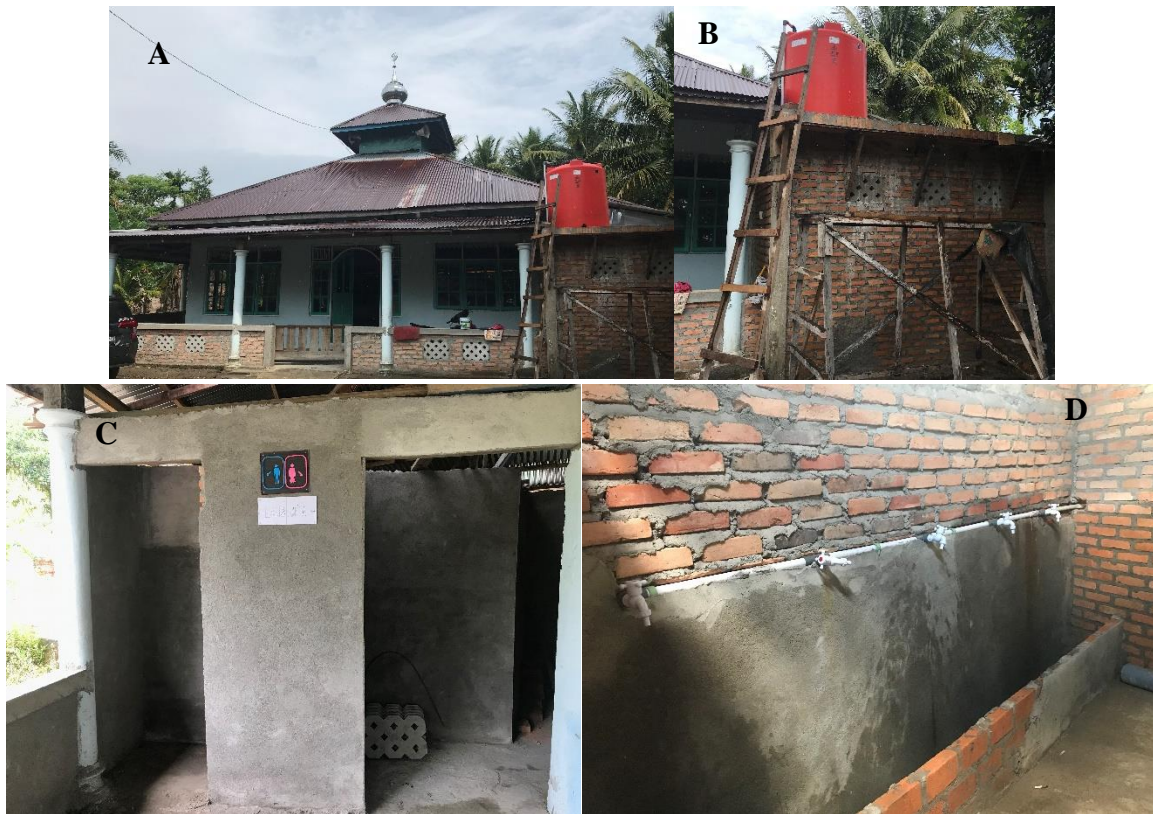
Gambar 2. Fasilitas air bersih yang sudah rehab, (A) tampak depan (B) bangunan bertulang dan atap beton dengan tangki air (C) tempat berwuduk dan (D) kran untuk berwuduk dengan sumber dari tangki air.
