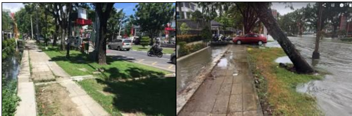
Gambar 5. Drainase Kanan Jl. Khatib Sulaiman saat kondisi normal dan banjir (dokumentasi 2017)
