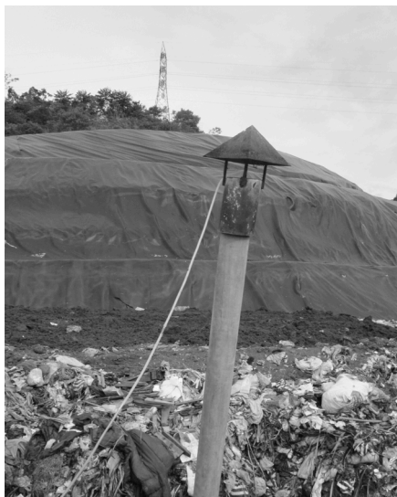
Gambar 3 Pipa Ventilasi Tegak Gas Metan di TPA Regional Payakumbuh
