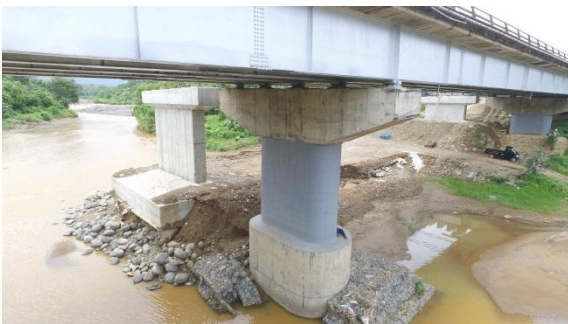
Gambar 3. Kondisi struktur bawah Jembatan Kuranji tahun 2017
