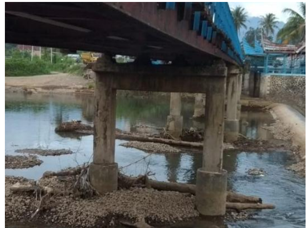
Gambar 10. Kondisi konstruksi struktur bawah dari Jembatan Gunung Nago.
