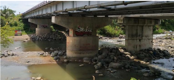
Gambar 8. Kondisi bawah struktur jembatan Air Dingin.
