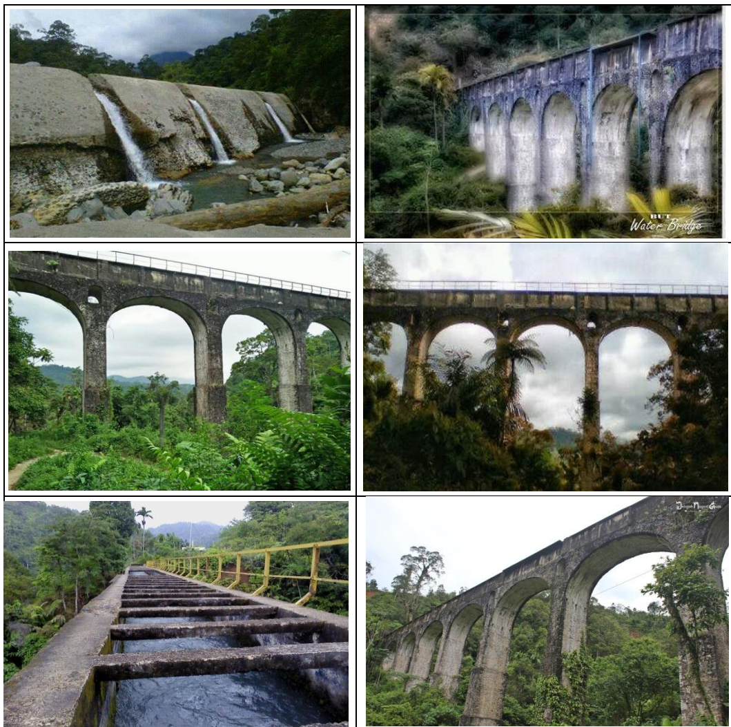
Gambar 8. Dokumentasi Situs Sejarah Bangunan PLTA PT Semen Padang di Kampung Batu Busuk Kelurahan Lambung Bukit
