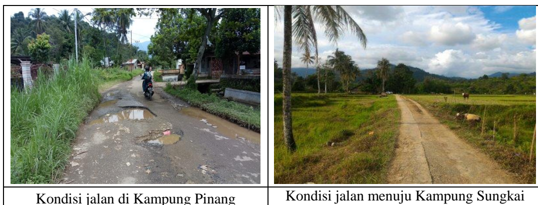
Gambar 7. Dokumentasi Kondisi Prasarana Pendukung di Kelurahan Lambung Bukit
