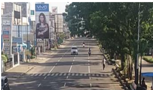
Gambar 3. Kondisi Jalan Lajur Efektif 4
