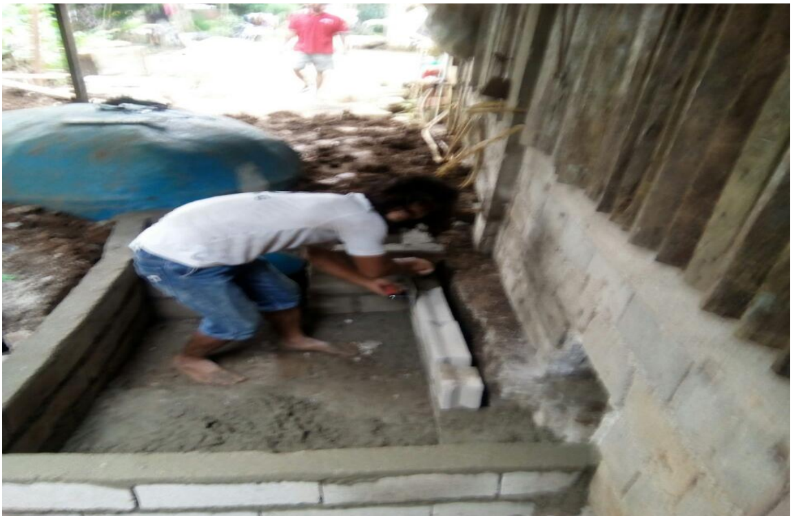
Gambar 9. Pemabuatan bak inlet dan bak outlet.
