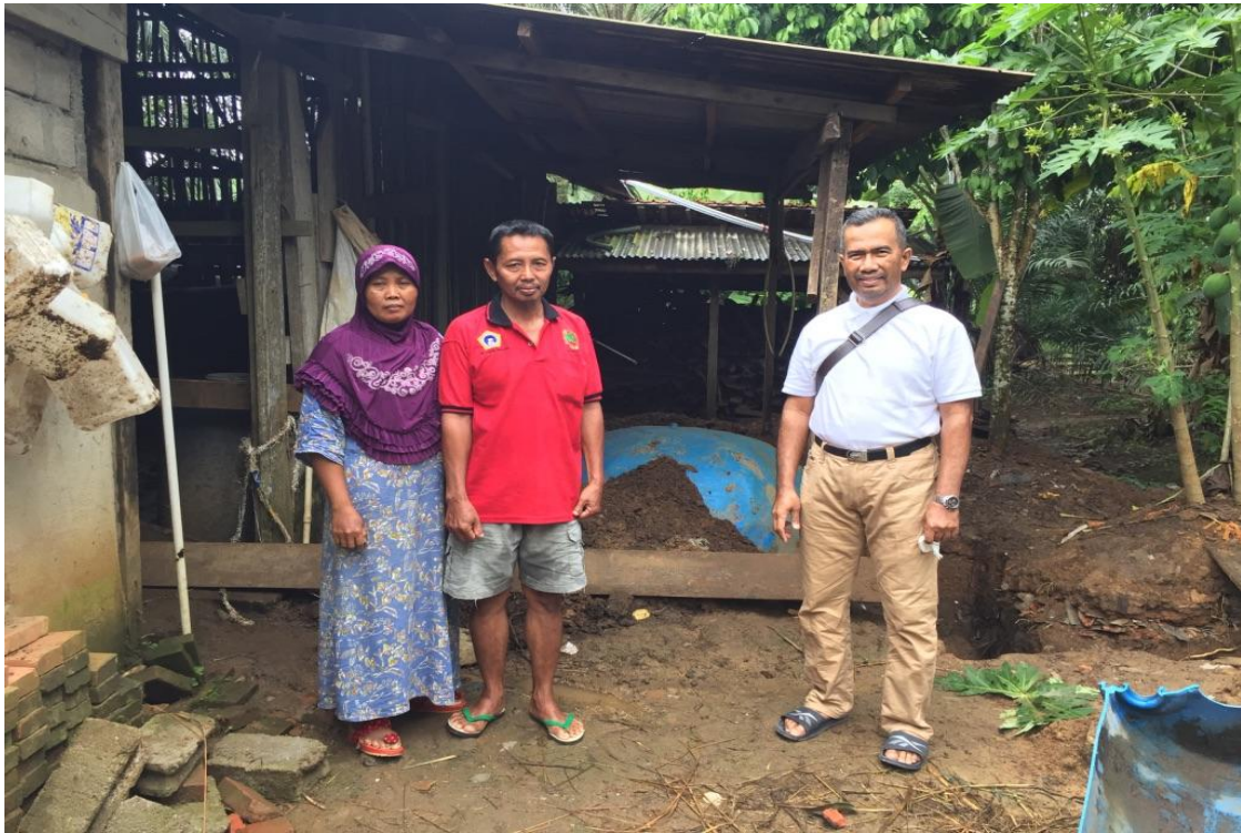
Gambar 12. Peternak yang menerima digester biogas yang dalam pengerjaan
