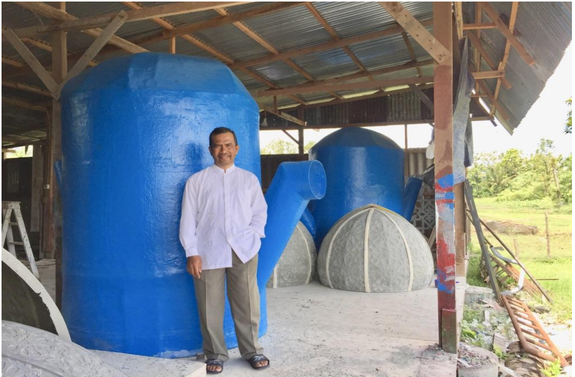
Gambar 3. Saat pengecekan dalam pembuatan digester biogas
