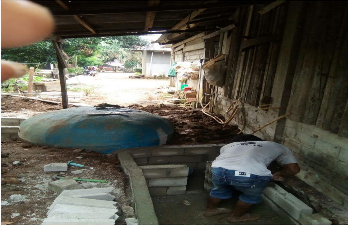
Gambar 8. Pemasangan unit digester biogas dan pembuatan bak inlet dan outlet.
