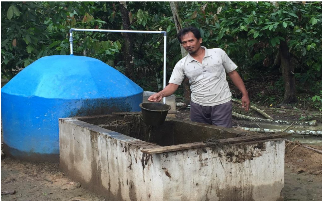
Gambar 11. Salah seorang peternak sedang mengambil feses ternak dari bak outlet yang akan digunakan sebagai pupuk organik
