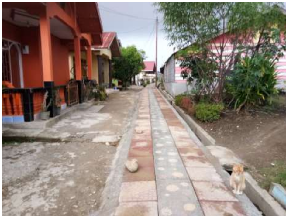
Gambar 5.3 Pembangunan Jalan Paving Slope
