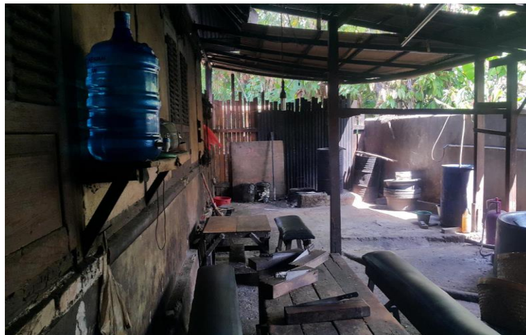
Gambar 4. Ruang Produksi Sebelum di renovasi
