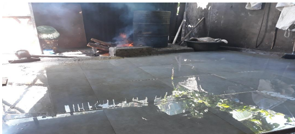
Gambar 5. Ruang Produksi Setelah Renovasi
