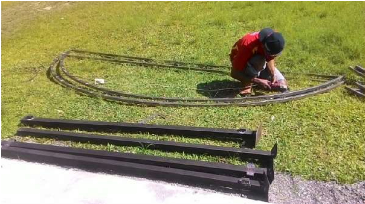
Gambar 4.2. Kerangka atap rumah pengering
