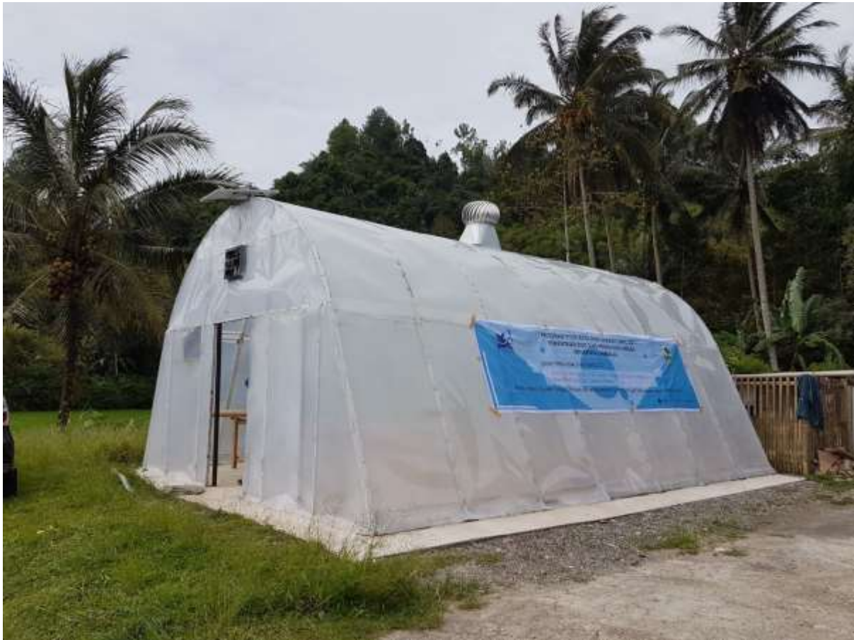
Gambar 4.4. Rumah pengering dengan menggunakan sistem kontrol temperatur dan kelembaban
