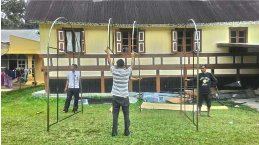
Gambar 3. Kerangka atap rumah pengering
