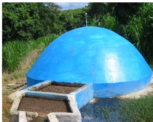
Gambar 2. Bangunan Bioreaktor Tipe Fixed Dome BBP Mektan Serpong
